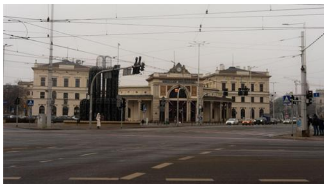
Fot. 2. Zabudowa w obrębie wyznaczonego obszaru, fot. Kamil Hodera
